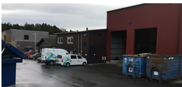
Figur 15 set fra nord mot sør viser henholdsvis lagerhall, adm.bygg og Bruktbo Kilde: Rambøll 03.09.2024
