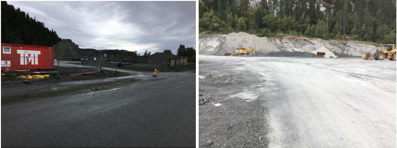
Figur 25 viser tomt i Tønsåsen under opparbeiding. Kilde: Rambøll 03.09.2024
