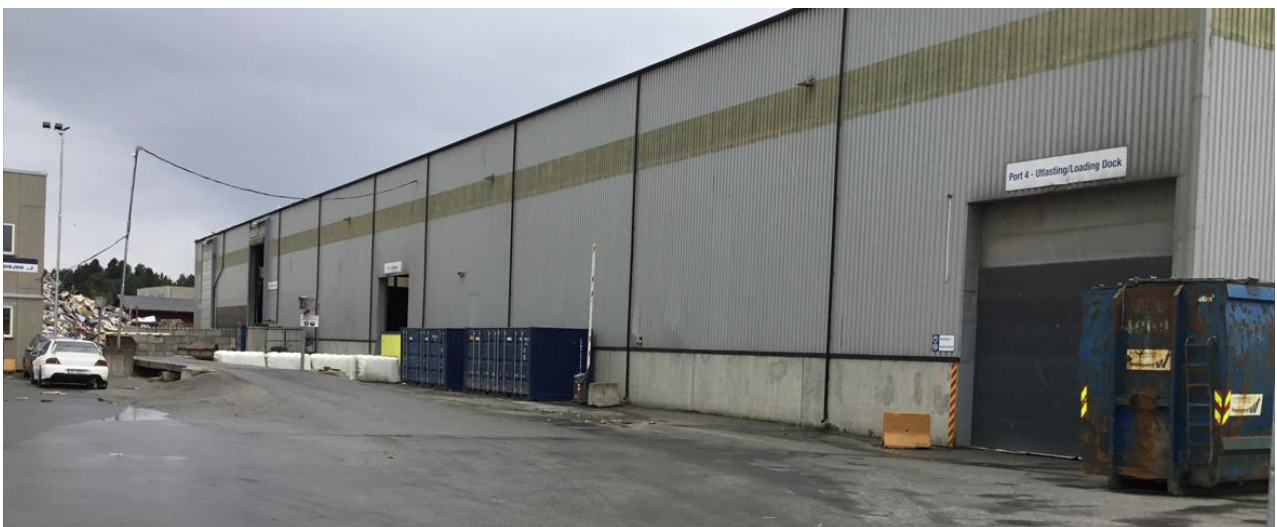
Figur 16 a og b viser deler av omlasteanlegget hos IDW i Industriveien 13. Kilde: Rambøll 03.09.2024
