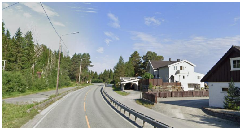
Figur 4 Fv 905 med autovern mot gang- og sykkelveg og bebyggelsen på nordsiden av vegen
